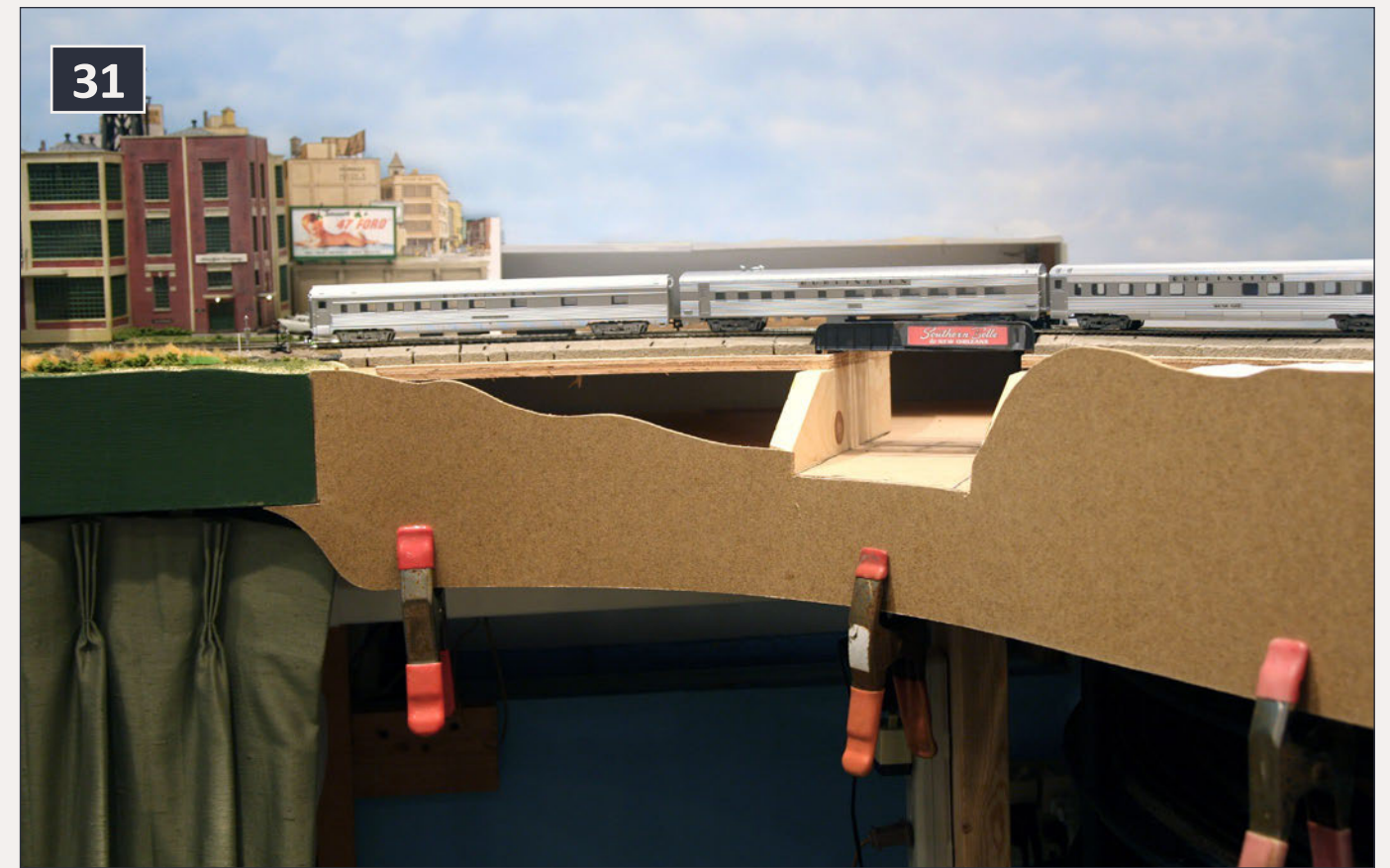
31: Installing the fascia.
